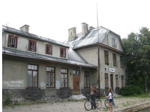
Grójecka Kolejka Dojazdowa – przestrzenny układ komunikacyjny Grójec ul. Przedstacyjna
