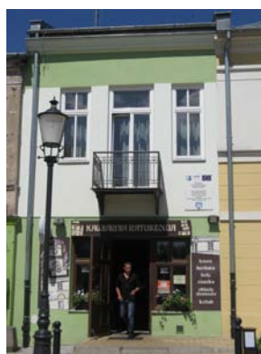
Budynek mieszkalny Grójec ul. Plac Wolności 2
